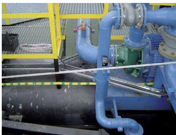
Fot. 3. Pompa monoblokowa ON-125 DB do zasilania głowicy
